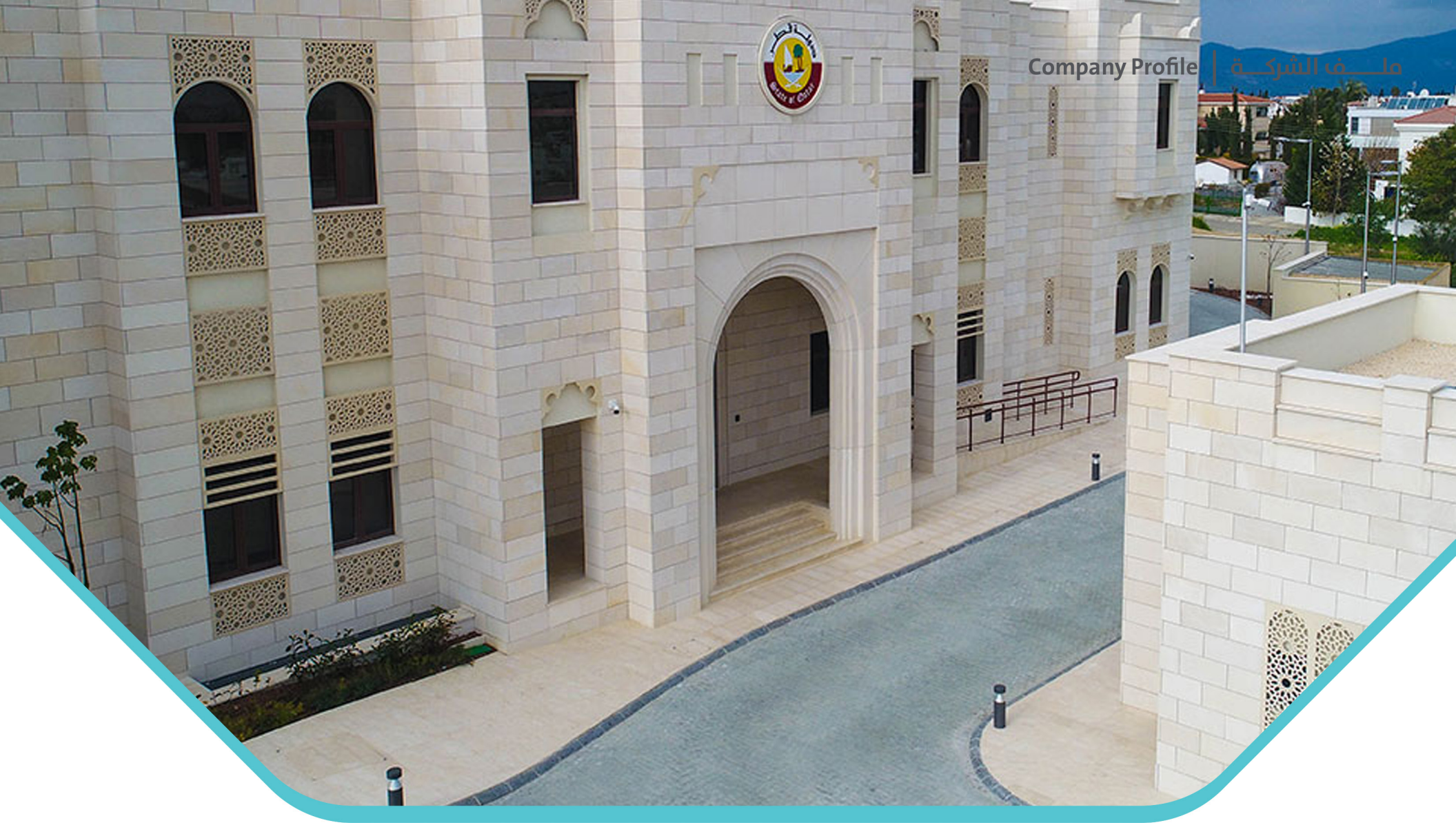
مشاريع الالكترومكانيك (MEP) Qatar Embassy and His Excellency the Ambassador's residence
